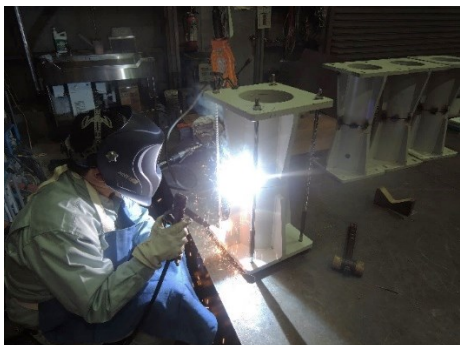
図4. 被覆アーク溶接による点付け溶接
