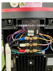
図9. ポンプ結線(逆転) 図10. ポンプ結線(正転)
