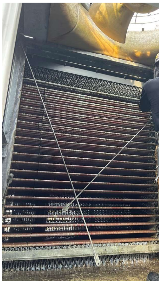
図5. 充填材を取り外して銅管コイル周辺の点検等をしている様子
