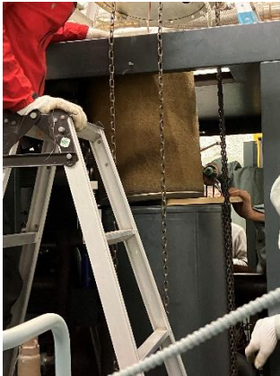
図 10. 引き抜かれたオイル セパレーター 汚い
