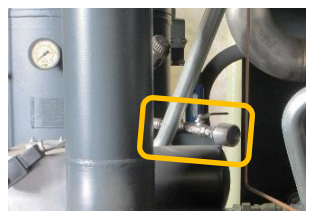
図 4 圧抜き箇所 左: V2114、右: V2115
