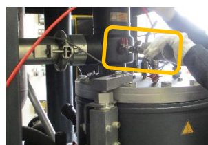
図 4 圧抜き箇所 左: V2114、右: V2115
