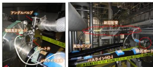
図 6 バスライン真空排気系の改善結果
