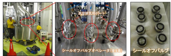
図8 バスライン予冷用断熱二重配管シールオフバルブの交換、左図：作業の様子、中央及び右図：シールオフバルブの詳細
