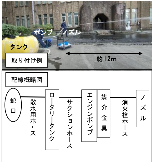
図3 排水ポンプを使用した訓練装置一式
