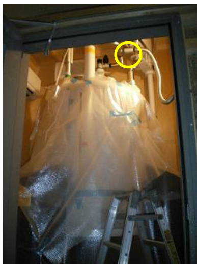
図4 従来の逆止弁の位置
