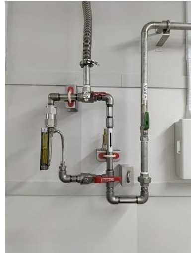
図5 新規増設した切り替えライン
