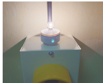
図 5 回転灯改造後のランプ部
