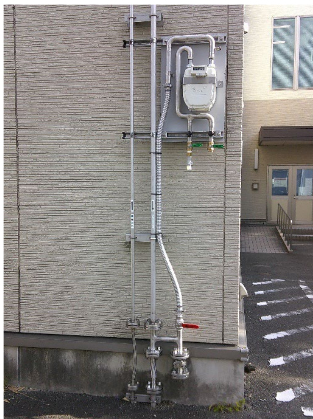
図 14 既設配管に新設した回収受入口
