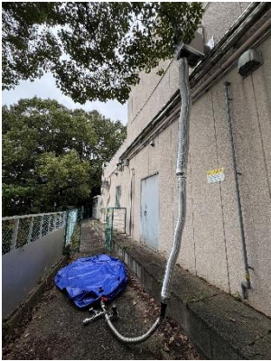
図 2 貯水袋と クエンチダクトの接続
