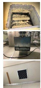
図4. 天井排気口とフィルターボックス
