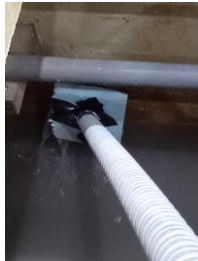
図5 埋設排水管出口を一時的に閉鎖
